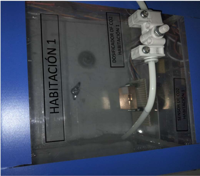
Detalle de una habitación con estrangulador y sensor de CO2
